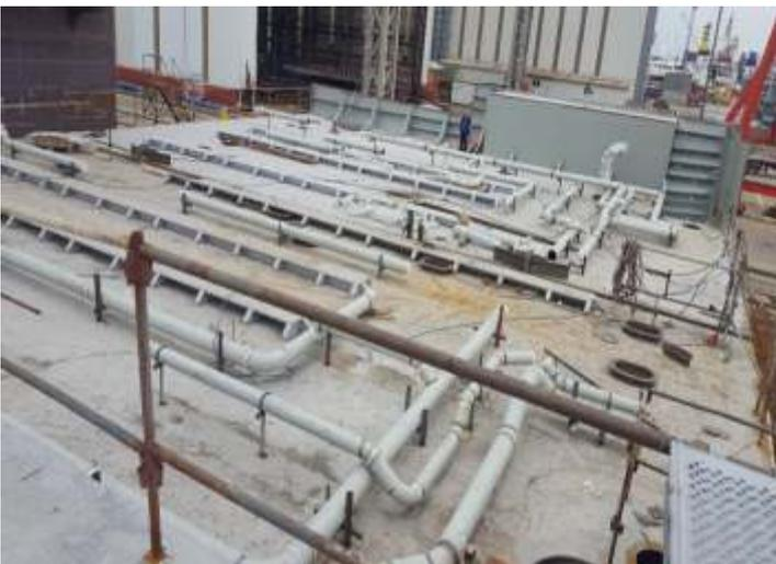
Многоцелевой авианосец-амфибия на стадии строительства. Установка трубопроводов
